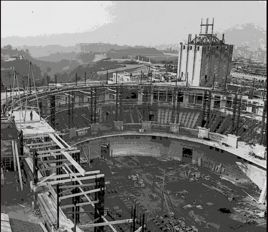
Sala oval en construcción, 1928
